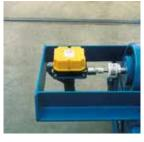
ENCODER + SPINDLE LIMIT SWITCH
